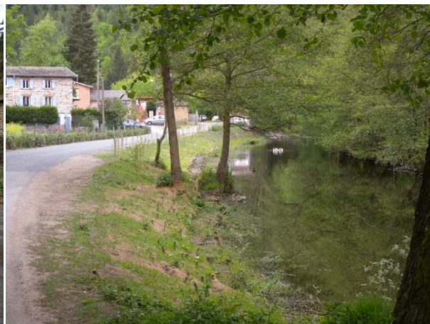
Photo 1 : Secteur avant travaux : berge inexistante et érodée. Chemin partiellement emporté
